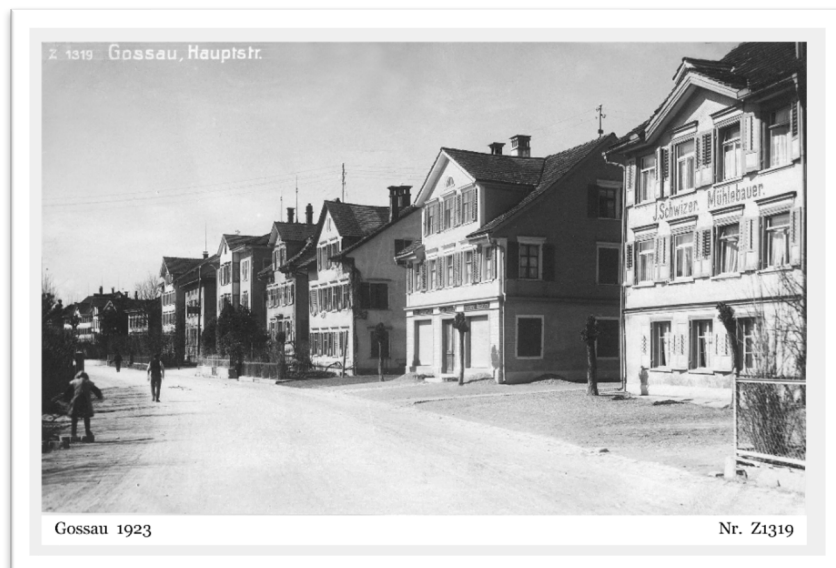
Hauptstrasse (Gossauer-Archiv)- Haus Leutenegger 2. von rechts
